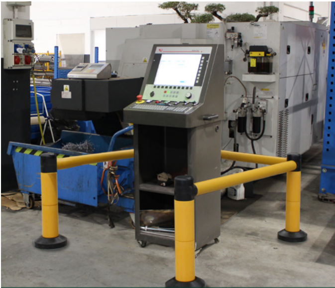
Bollards a protezione di macchinari
