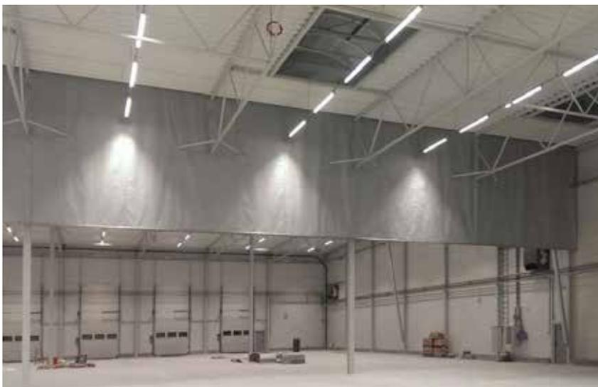
**Tenda tagliafuoco a secco a doppio telo** fino al livello di protezione EI 120. Sono composte da un doppio telo in fibra di vetro e fili di acciaio con spalmatura in silicone. Dimensioni massime: **10.000 mm X 16.000 mm.**
