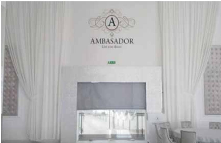
**Tende tagliafumo** conformi alla EN 12101-1 in classe D120. Costituite da una speciale fibra di vetro, dallo spessore di 0,4mm [455g/m<sup>2</sup>], di colore grigio alluminio e rivestita su entrambi i lati con poliuretano. Testate ad una temperatura di 600°C fino a 120 minuti.
